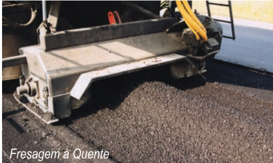
Pré-aquecimento e Fresagem à Quente
